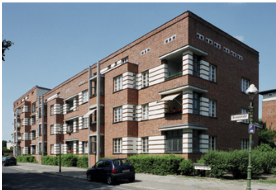
„Neues Bauen“ – Die Siedlung Schillerpark im Wedding
